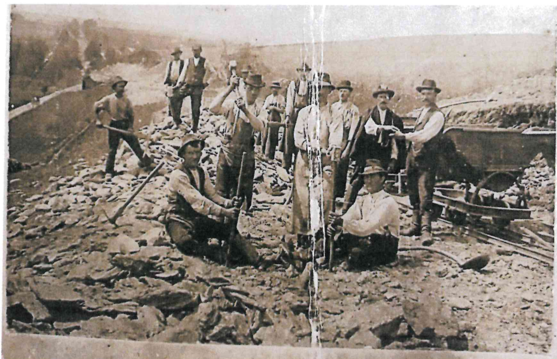
Abb.7: Fleißige Helfer bauen eine neue Straße durch den Ort. Eine eigens eingerichtete Klein-schienenbahn mit Kipplorenbetrieb erleichterte den Transport vor Ort erheblich.
